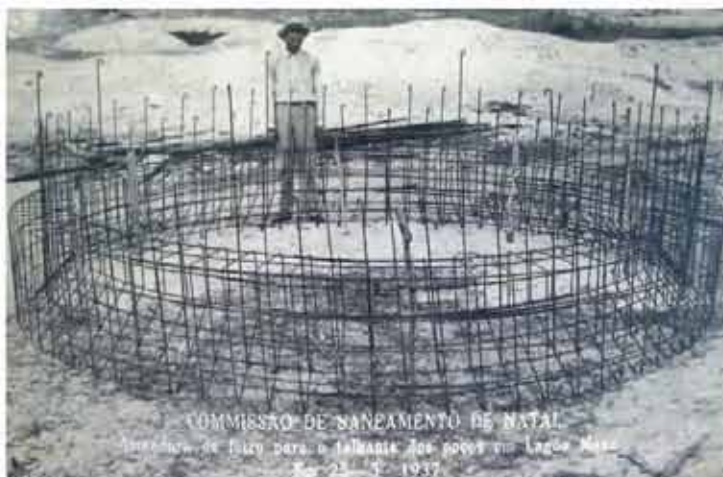
Figura 01: Obras da Comissão de Saneamento de Nata em Lagoa Nova - 25/03/1937 Fonte: IHG/RN
