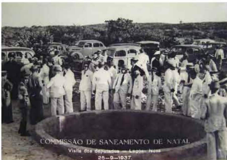
Figura 02: Visitas dos Deputados as obras da Comissão de Saneamento de Natal - 25/09/1937 Fonte: IHG/RN
